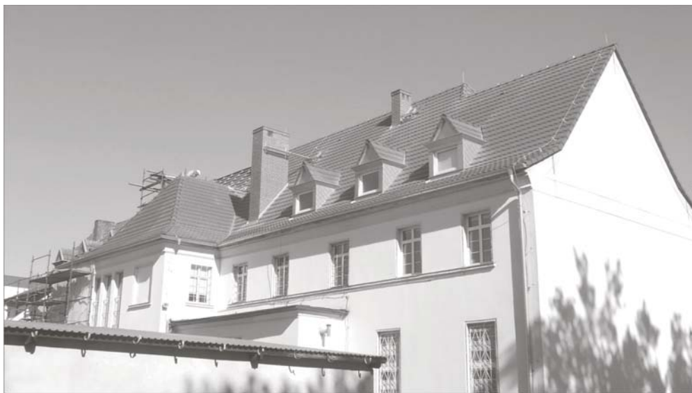
Wymiana pokrycia dachowego na budynku Urzędu Miejskiego
