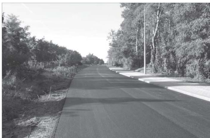
Nowa nawierzchnia ulicy PCK
