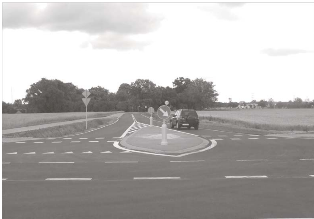
Wjazd na obwodnicę od strony drogi powiatowej: Zbąszynek -Dąbrówka Wlkp.
