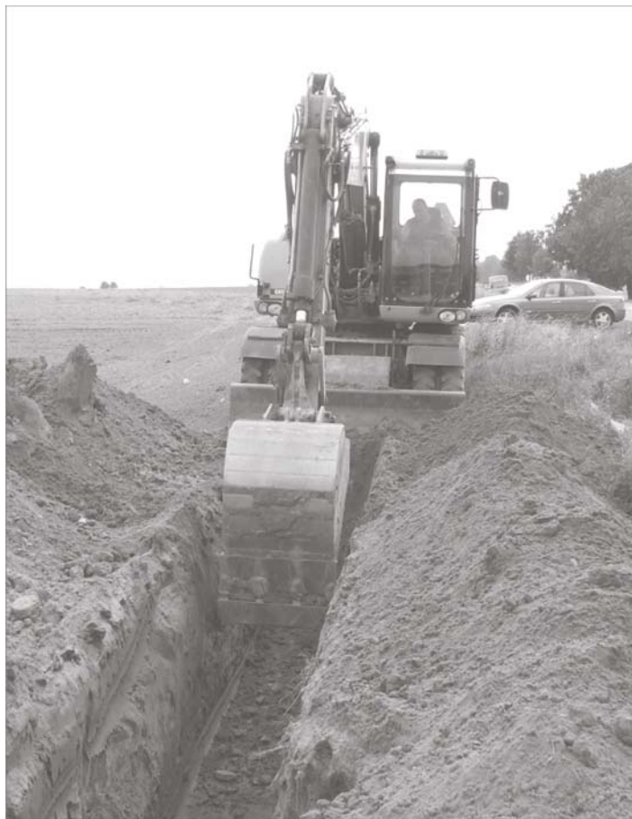
Budowa kanalizacji w kierunku Rogozińca
